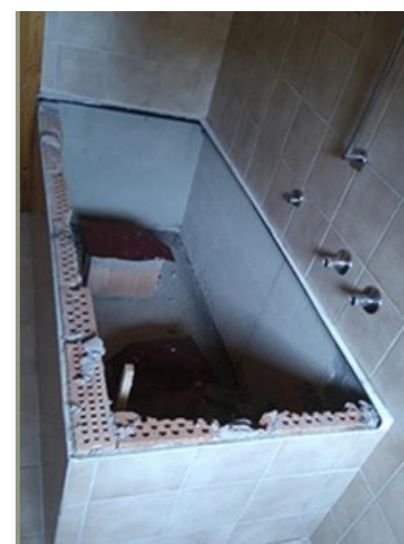
2. Die neue Badewanne wird präpariert und an alter Stelle eingebaut.
